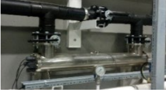
AKOSB AAT ileri arıtma üniteleri (Ultrafiltrasyon, Aktif Karbon, Ters Osmoz ve Ultraviyole Dezenfeksiyon)
