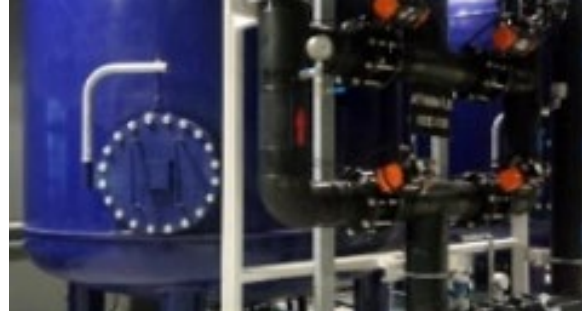
AKOSB AAT ileri arıtma üniteleri (Ultrafiltrasyon, Aktif Karbon, Ters Osmoz ve Ultraviyole Dezenfeksiyon)
